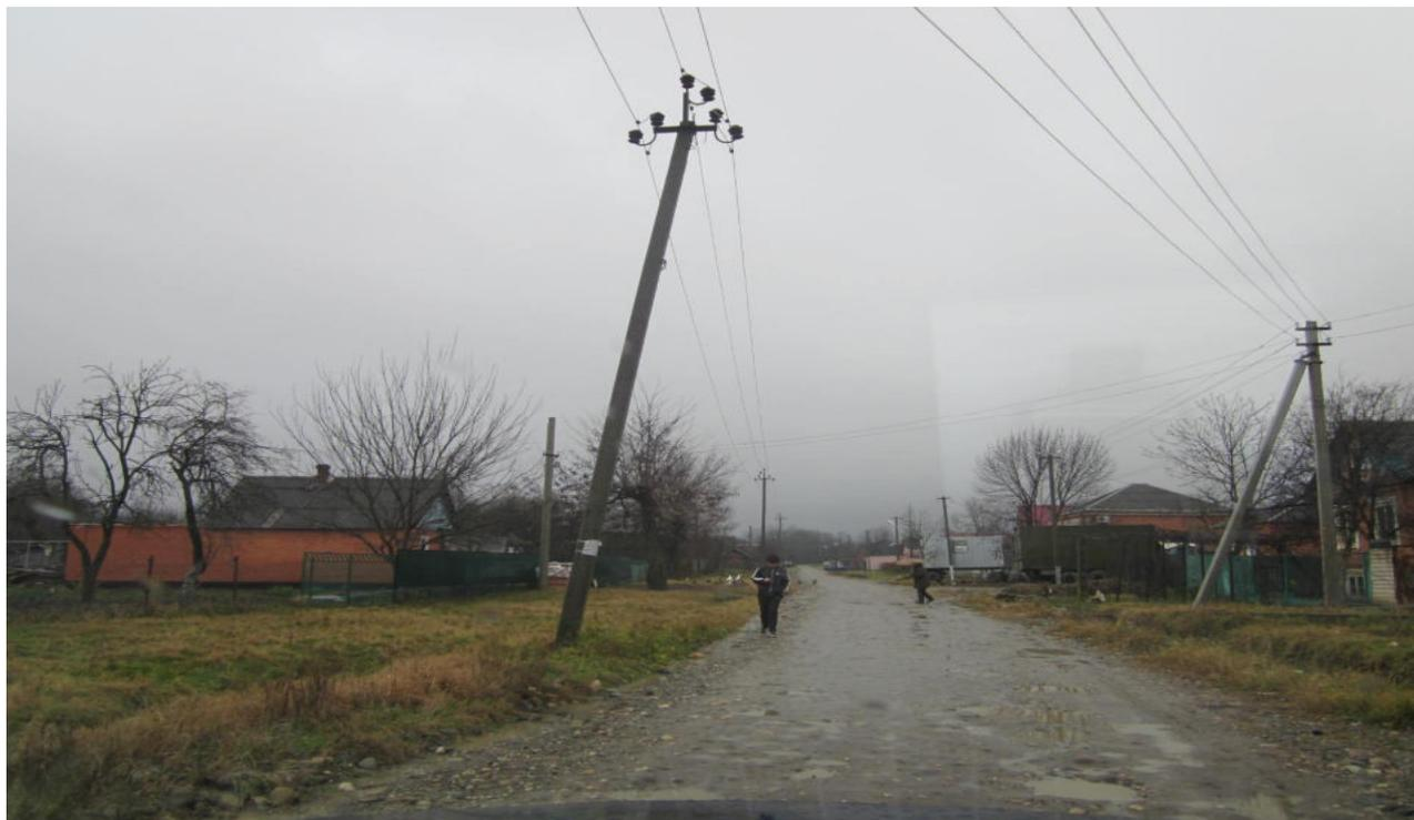
*Опора линии электропередач. х.Шаумян. Столб сильно наклонен. Создает угрозу жизни населения.*
