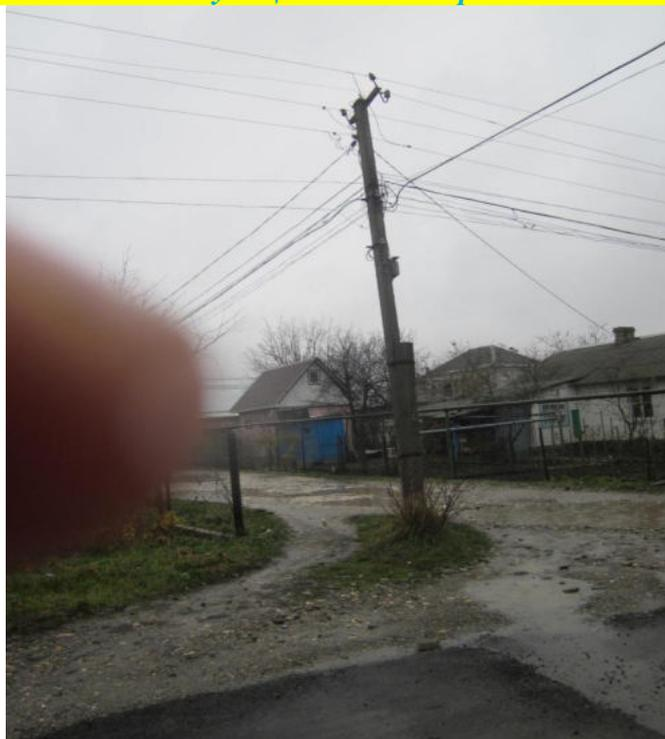
*Опора линии электропередач. Стоит посередине улицы. Наклонен. Ограждения нет.*
