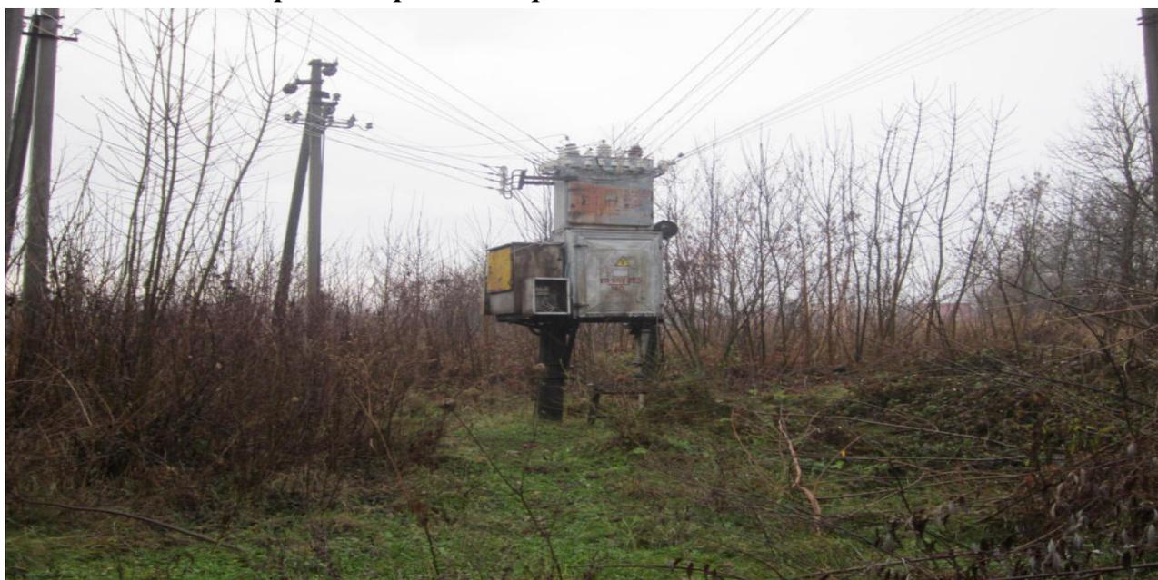
*Трансформаторная подстанция – 100 кВт. п.Удобный. ул.Ленина. Трансформатор ржавый. Замаслен. Нет надписей. Подвод на скрутках.*
