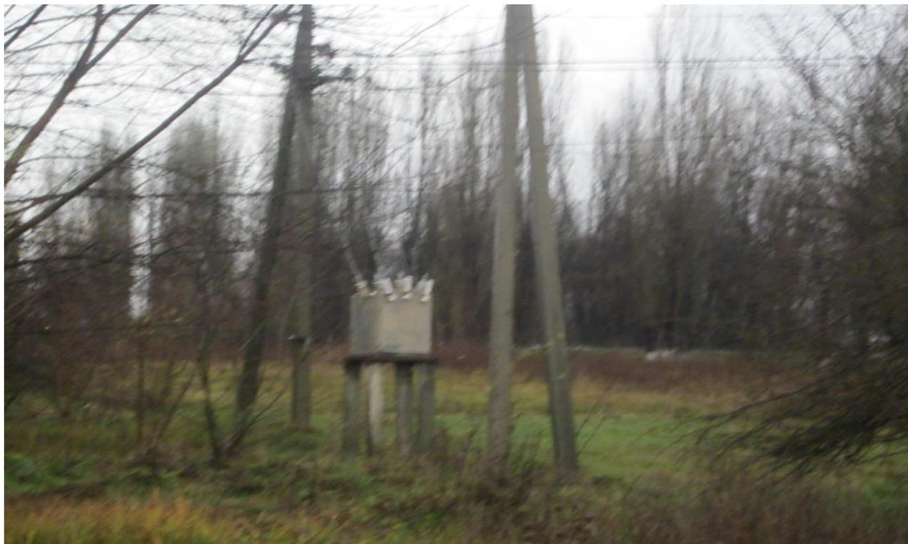
*Трансформаторная подстанция – 100 кВт. ул.Восточная. Трансформатор замаслен. Надписи отсутствуют. В кустах стоит.*
