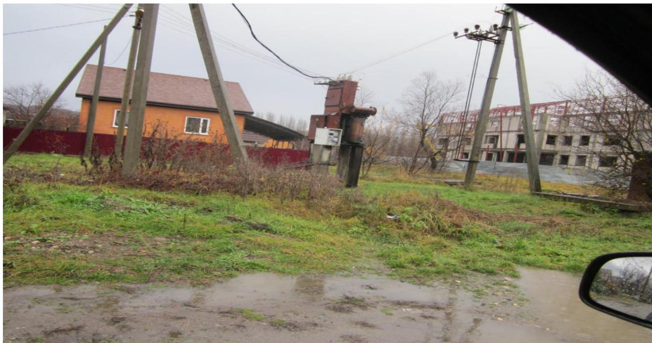
*Трансформаторная подстанция – 100 кВт. п.Совхозный. ул.Восточная. Трансформатор замазлен. Ржавый. Надписей нет. Подвод на скрутках.*
